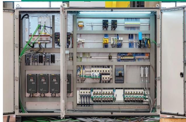
L'impianto elettrico/elettronico è stato progettato e realizzato adottando un sistema a BUS DI CAMPO, con conseguente semplificazione del cablaggio, garantendo una diminuzione della possibilità di guasti ed, eventualmente, una più rapida e puntuale ricerca degli stessi. Abbiamo seguito le linee guide dettate dai canoni di "Industria 4.0", così da rendere la macchina già compatibile con le future tecnologie.
